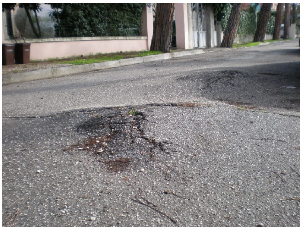
Un eloquente esempio di come le radici, in tutto il quartiere, abbiano seriamente compromesso il manto stradale.
