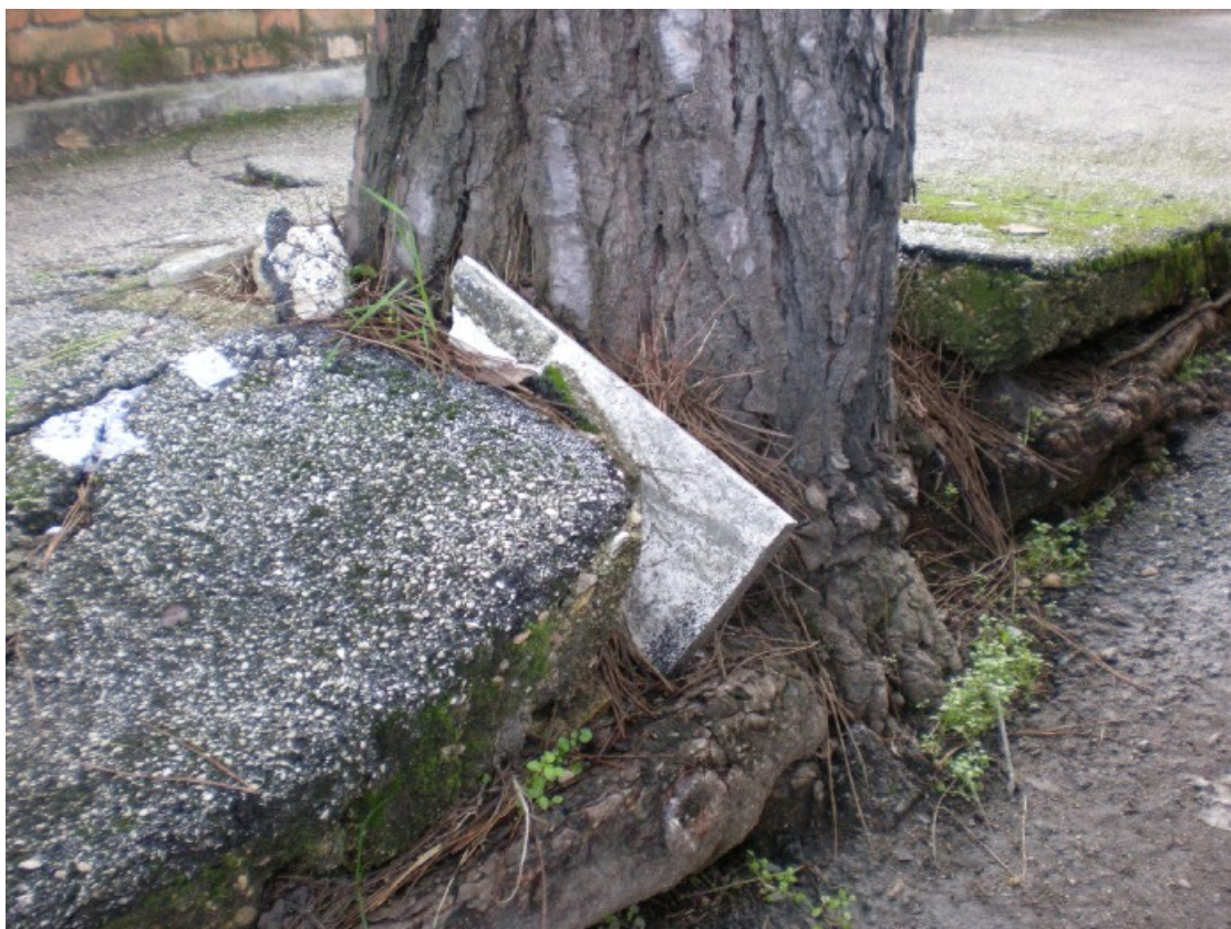
Via A Garibaldi: Tratto di marciapiede divelto dalla normale crescita del tronco e dallo sviluppo delle radici
